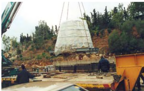
Διαδικασία μεταφοράς και τοποθέτησης του συρού.
