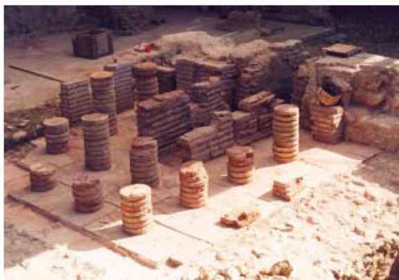
Τελική κατάσταση του υποκαύστου του βαλανείου.
