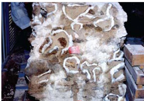
Διαδικασία στερέωσης της λιθοδομής του βαλανείου
