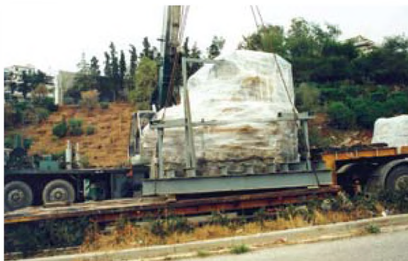
Διαδικασία μεταφοράς και τοποθέτησης τμήματος του υδραγωγείου.
